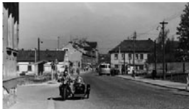
Dnešní Obchodní náměstí v roce 1962. Pohled od Lidového domu
