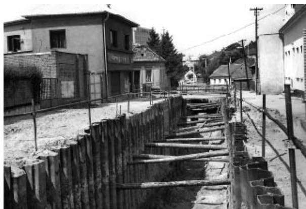
Stavba kanalizace na Dolnocholupické silnici (1990) 98
