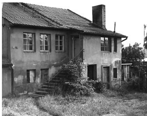
Bývalá obecní šatlava (čp. 66)
