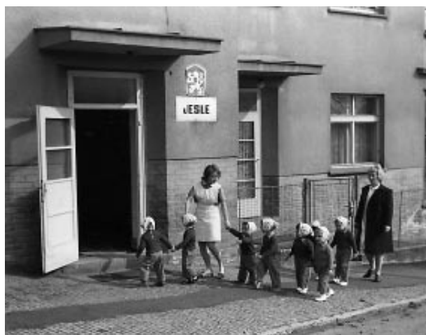
Mateřská škola Pod sady byla postavena roku 1940 z iniciativy spolku Ochrany matek a kojenců
