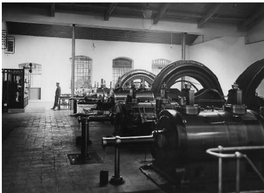
Elektrárna modřanského cukrovaru
