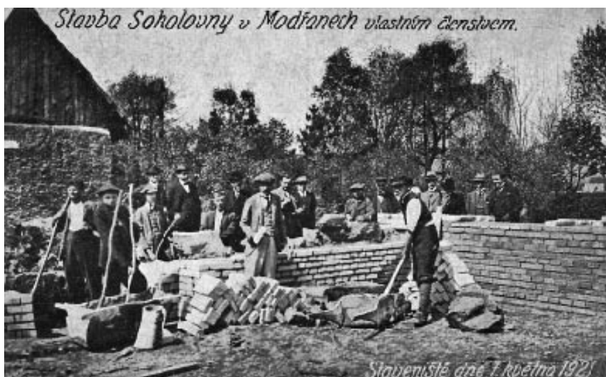
Ze stavby modřanské sokolovny (1921)
