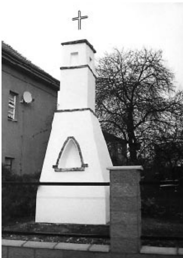
Modřanská boží muka po opravě
