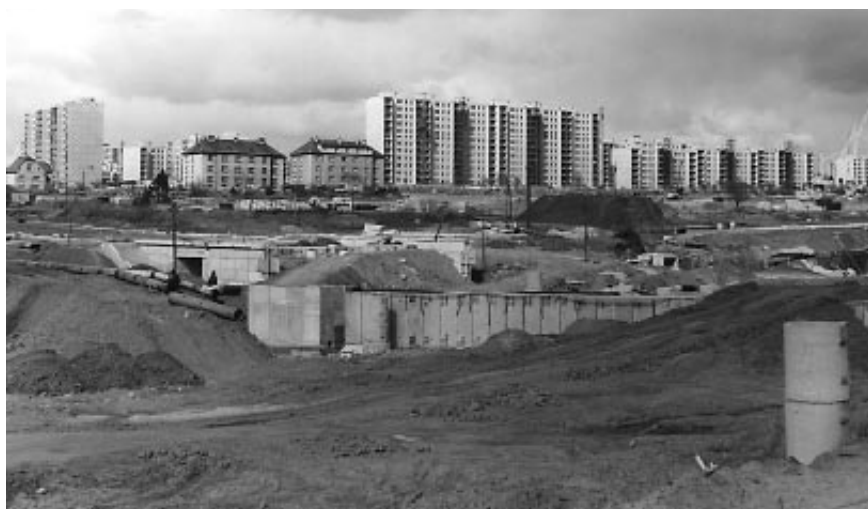
Budoucí střed Modřan roku 1982
